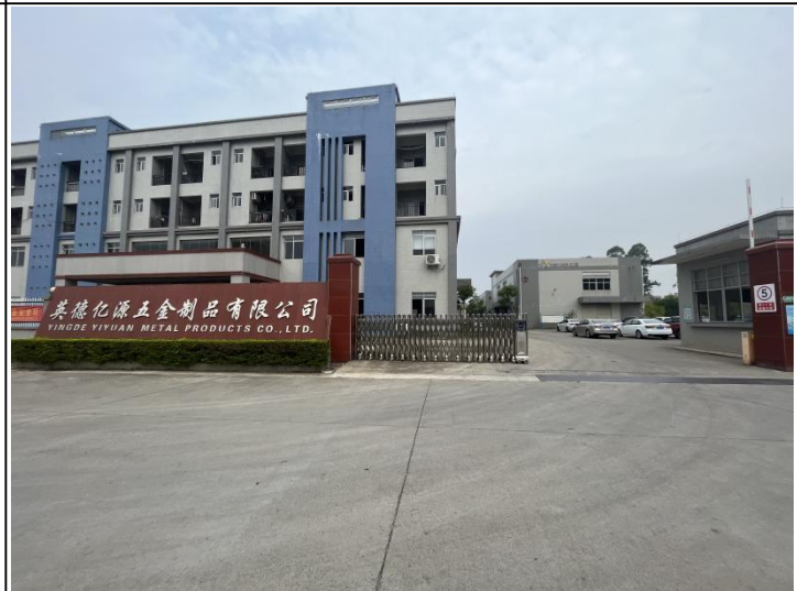
图片 4 项目东侧（亿源五金）
