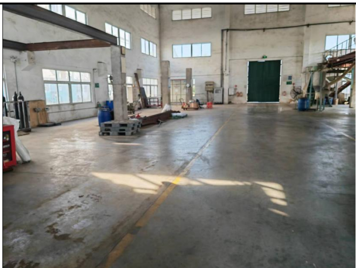
图片 2 项目丙类车间现状
