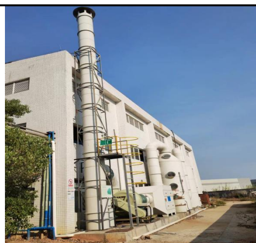
图 2 酸液喷淋+活性炭吸附装置+DA002 排气筒
