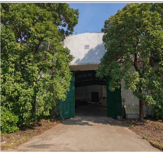
图 10 本项目依托的丙类仓库
