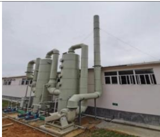
配酸间配酸废气：二级碱液喷淋塔
