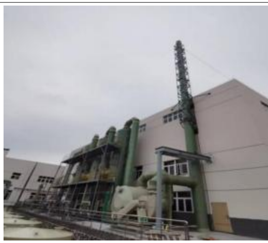
钽铌分离车间酸分解、萃取废气：二级冷凝+四级碱液喷淋塔
