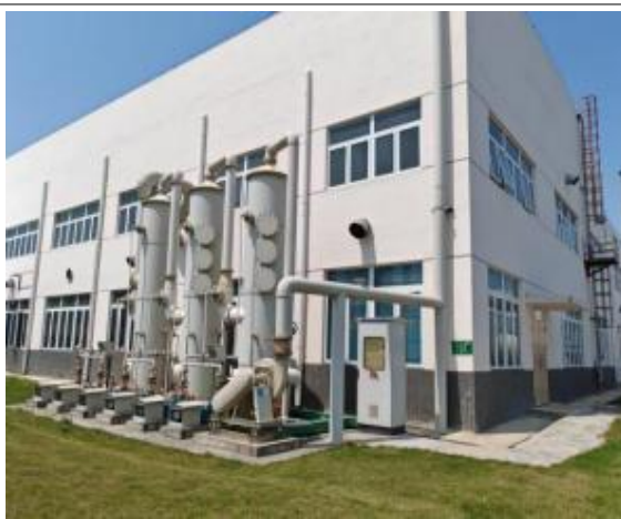
钽粉车间酸洗废气：冷凝+三级碱液喷淋塔
