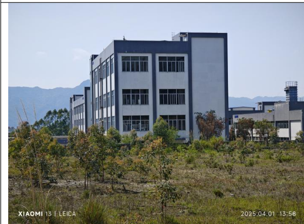
图 5 厂区西侧-清远贝特新材料有限公司
