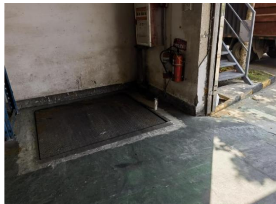
危废间收集池
