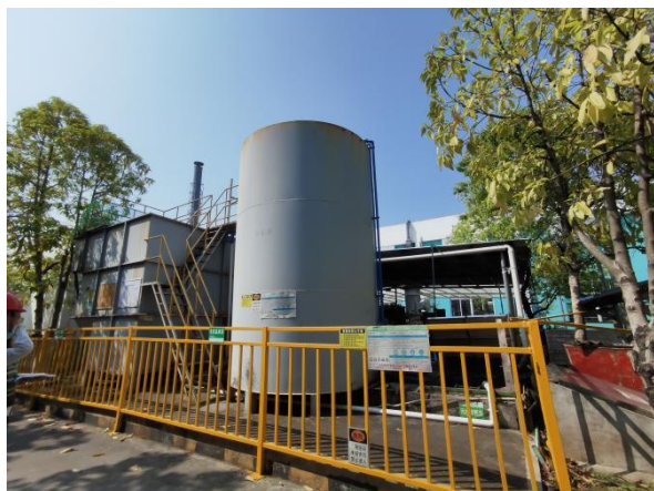
现有事故应急池（地下）
