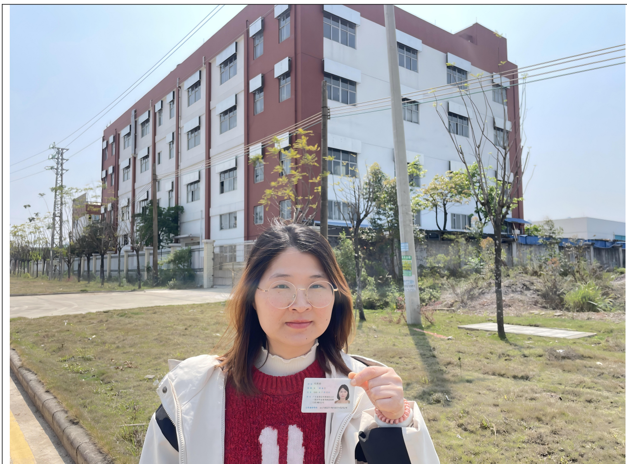
工程师现场踏勘图片
