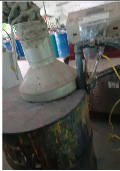
图 2-8 研磨工序废气收集措施
