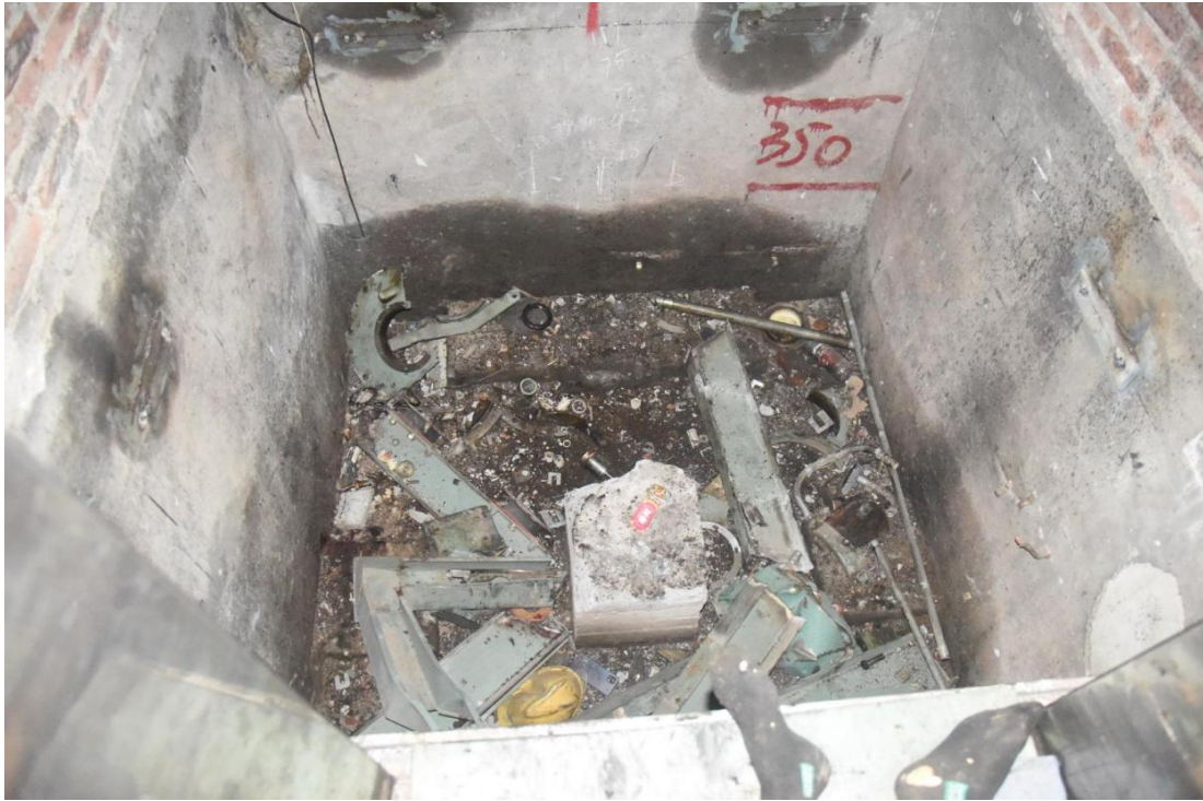
图 1 事故现场：电梯井底部发现有 11 楼电梯主机底座槽钢
