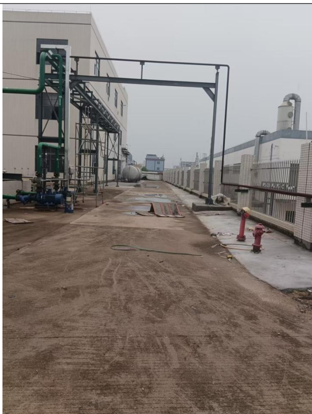
锅炉厂房西侧
