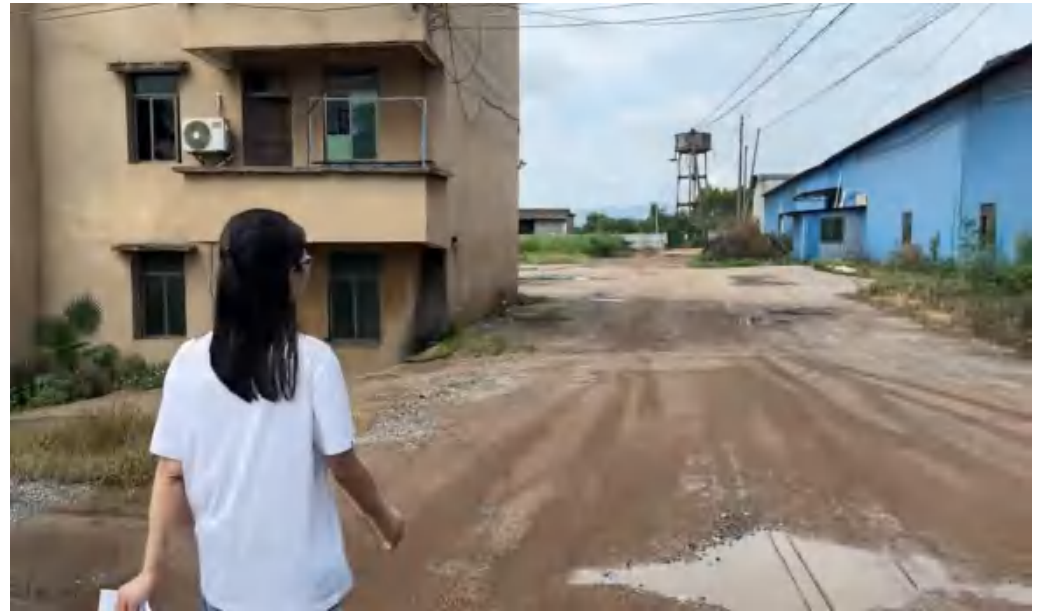
工程师现场勘察照片
