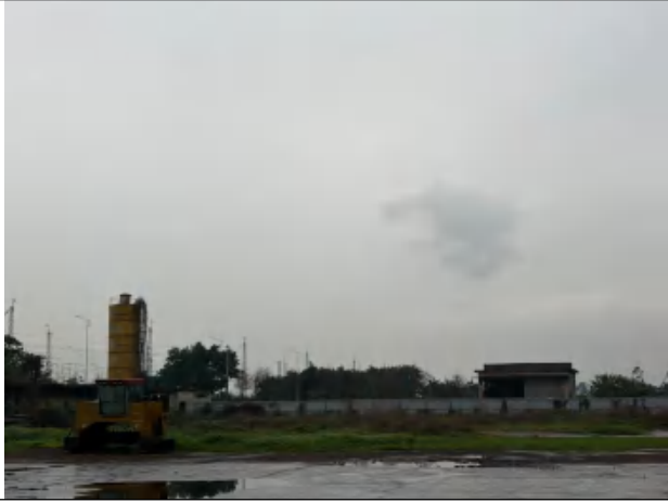
本改扩建项目待建设区
