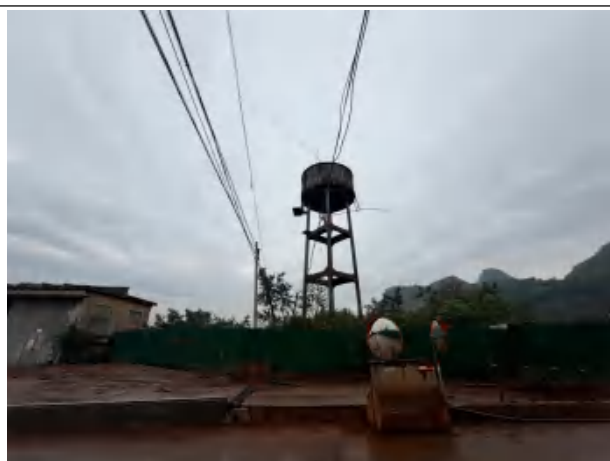
项目北面—闲置厂房及空地 (距本项目厂界 4m)
