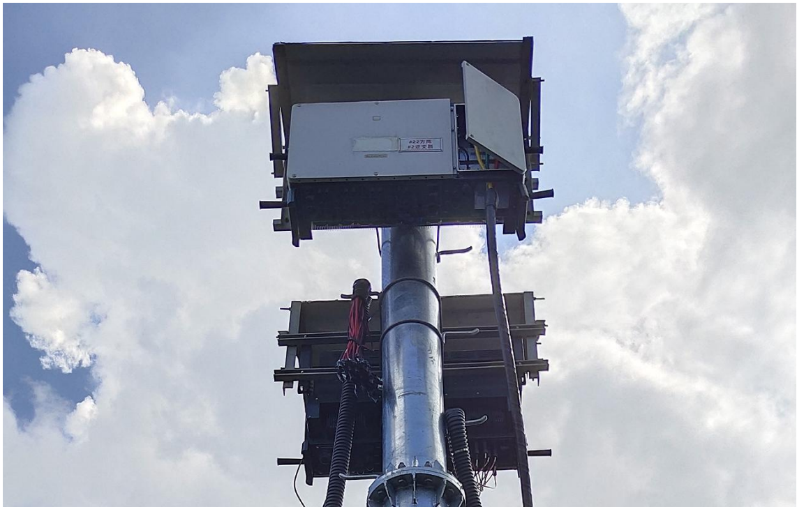
图 2 #2202 逆变器直流电缆已全部拔除
