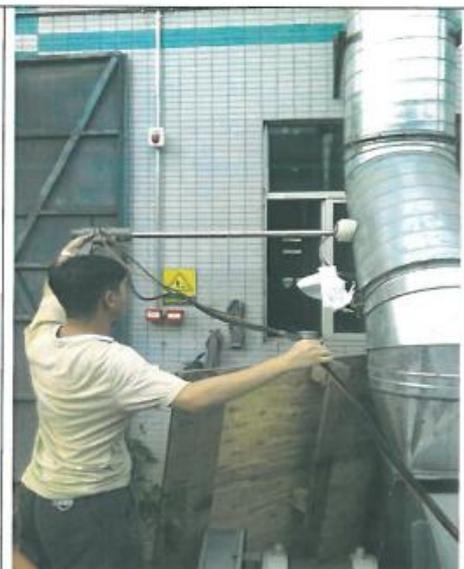
图 7.4 甲类 A1 车间 (3 条灌装线) 灌装工序废气处理后检测口 ©Q4
