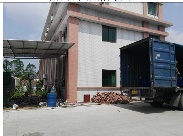
项目西面的办公楼
