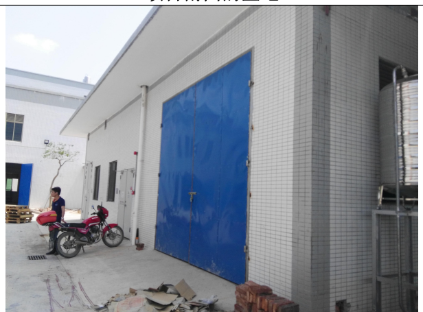
项目北面的配电房
